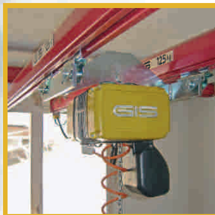
Траверсная спаренная каретка для двухбалочного крана
