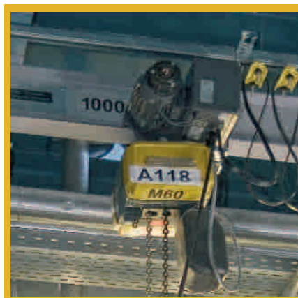
Электропривод передвижной каретки GIS
