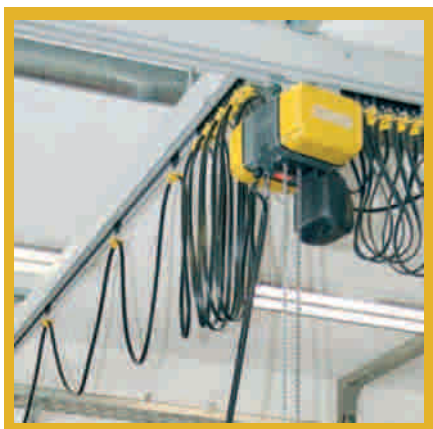
Гирляндный токопровод
